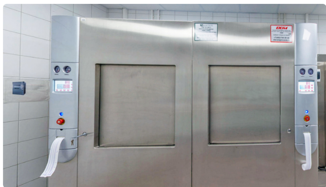
Паровые стерилизаторы PHS-400 проходного типа в составе ЦСО (вид со стороны чистой и стерильной зоны)
