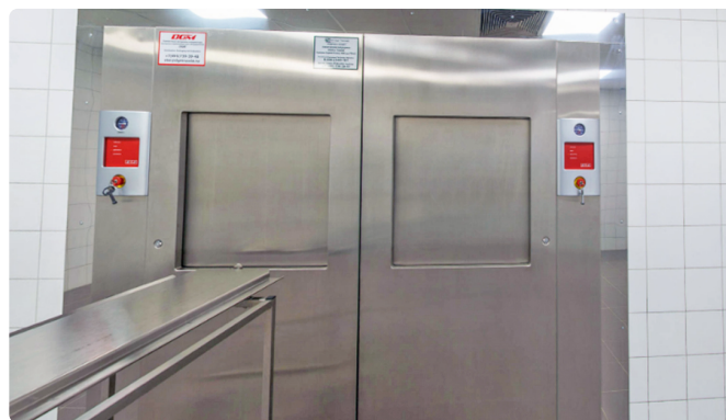
Паровые стерилизаторы PHS-400 проходного типа в составе ЦСО (вид со стороны чистой и стерильной зоны)
